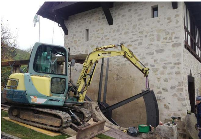
mit dem bagger werden die einzelnen vormontierten radsegmente zusammengebaut
