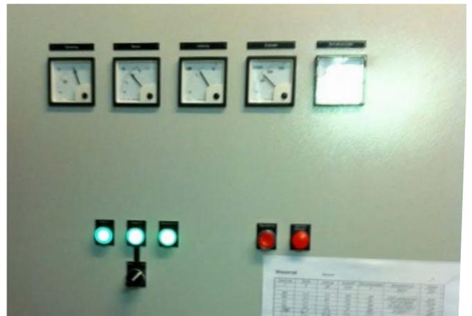
auf dem schaltschrank werden die nötigen parameter angezeigt wie betriebsstunden, drehzahl, leistung
